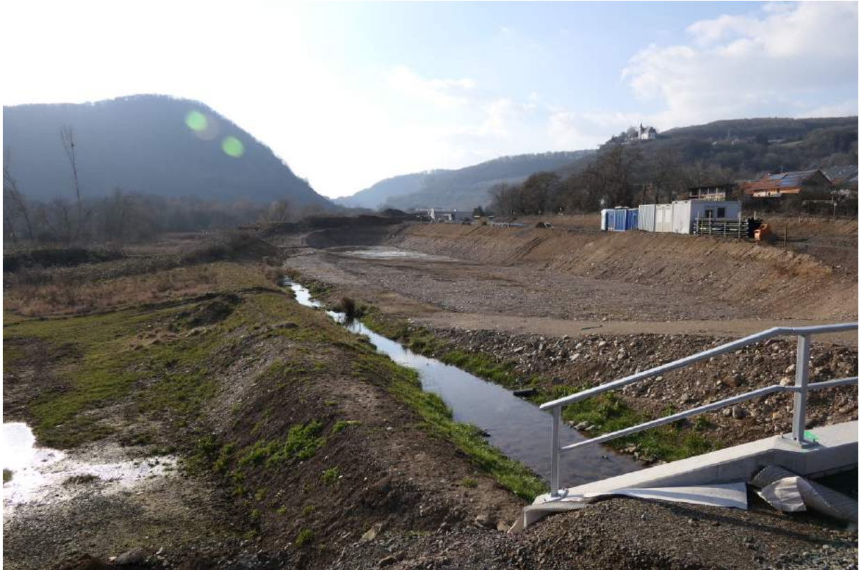
Abb. 3: Regenrückhaltebecken westlich der neuen Erschließungsstraße, verlegter Bachlauf
